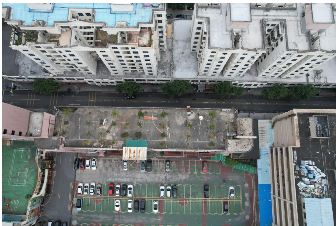
图 1-8 原商业学校现场航拍图
