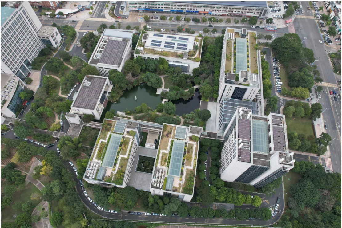
图 1-2 宏图技术中心现场航拍图
