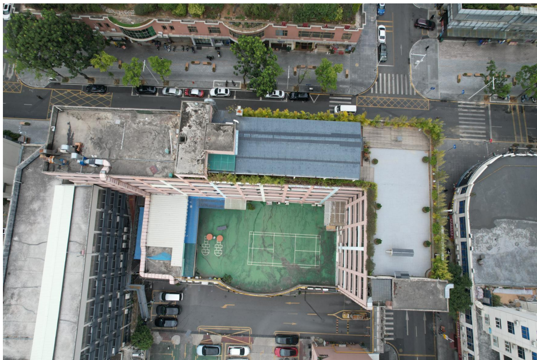
图 1-7 原商业学校现场航拍图
