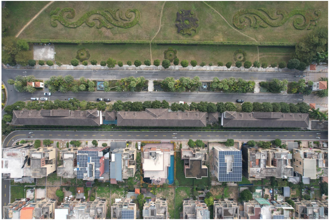
图 1-5 御花园物业办公楼现场航拍图
