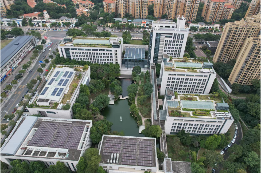
图 1-1 宏图技术中心现场航拍图
