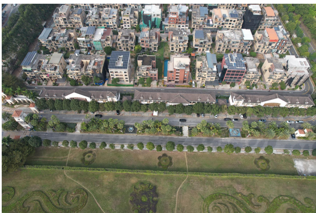
图 1-4 御花园物业办公楼现场航拍图
