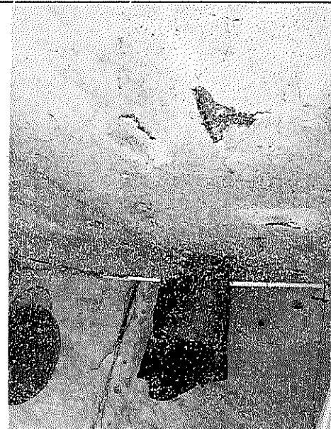
板底露筋照片
