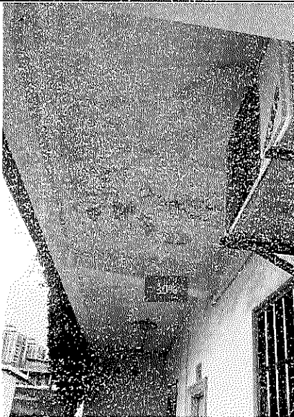
板底裂缝渗水照片
