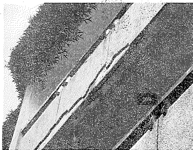
梁钢筋外露锈蚀照片
