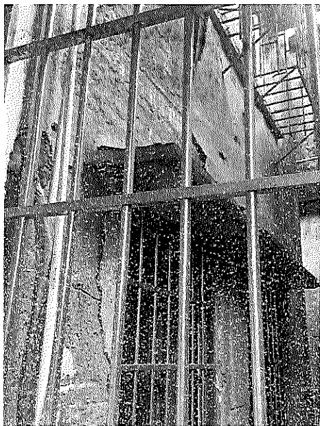
外墙装饰层风化脱落照片
