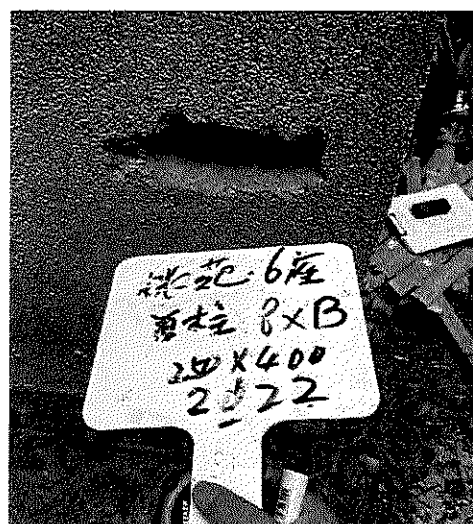
梁钢筋外露及锈蚀检测照片
