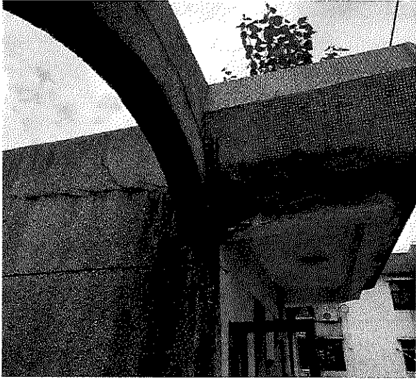
钢筋外露及锈蚀检测照片
