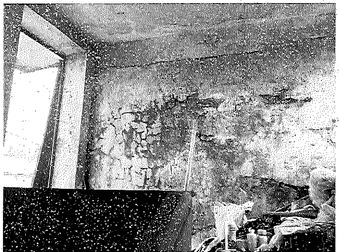
屋面板开裂渗水照片
