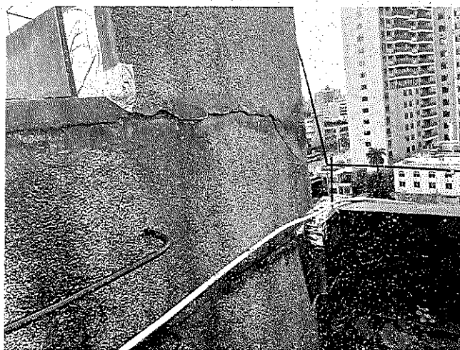
屋面板开裂渗水照片
