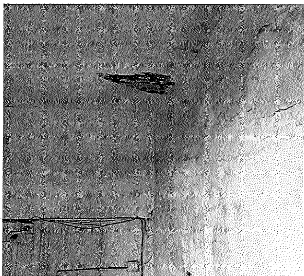
屋面板开裂渗水照片
