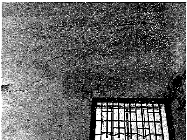
屋面板开裂渗水照片
