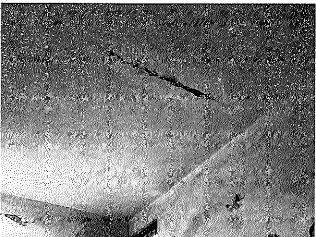
屋面板开裂渗水照片
