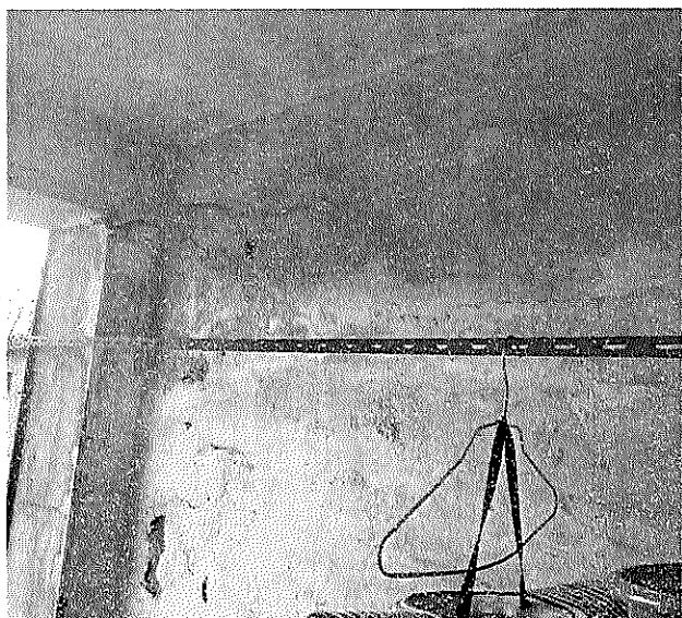
屋面板开裂渗水照片
